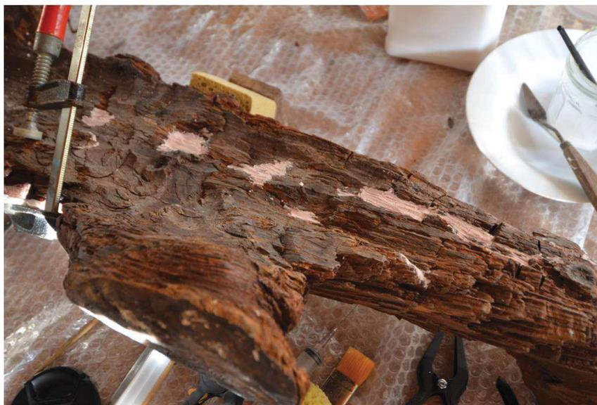
Consolidation par injections de produit et rebouchage des zones endommagées avec résine et/ou apprêt.
