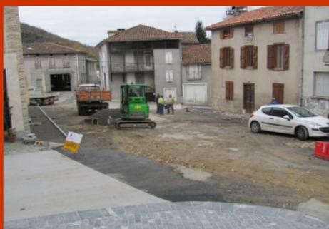
Dans la continuité de l'aménagement du centre bourg, la réhabilitation de la place St-Martin est en cours. Ces travaux, dont la maîtrise d'œuvre et la réalisation sont confiées au SIVOM, consistent à la remise en état du réseau pluvial, à la mise en accessibilité pour les personnes à mobilité réduite des trottoirs, à la réfection de la chaussée et à l'organisation du stationnement.
