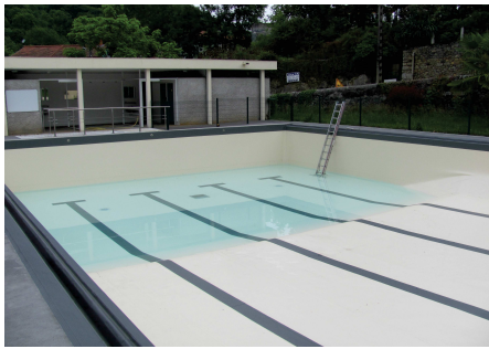
Piscine après la pose du liner
