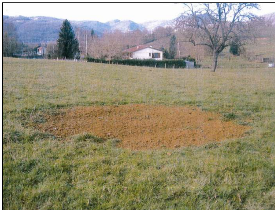
Figure IV.7: Fontis (probablement induit par des phénomènes de suffosion) comblé (Cliché RTM 31).
