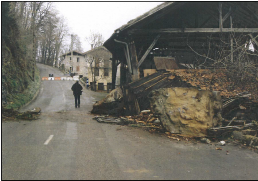
Figure IV.1: Chutes de blocs survenue à Aspet (Castera) en janvier 2013 (photo RTM 31/09).
